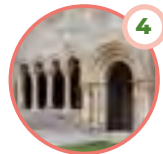
PÓRTICO ROMÁNICO DE REBOLLEDO DE LA TORRE
