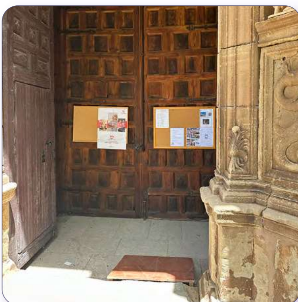
Espacio entre las dos puertas
