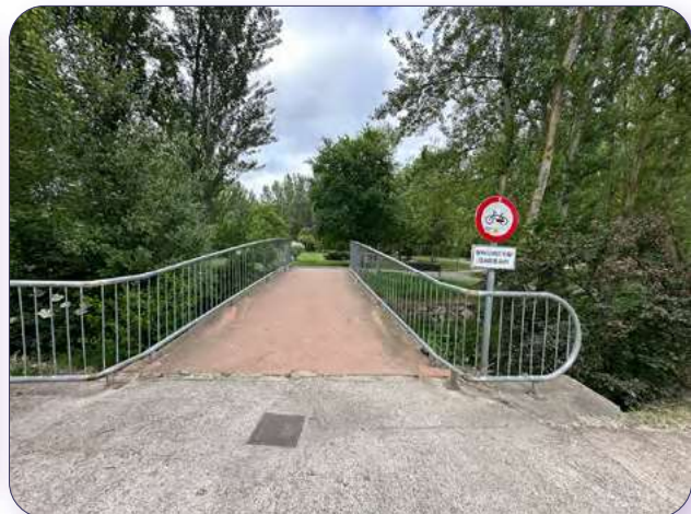
Puente de acceso al Parque de la Isla
