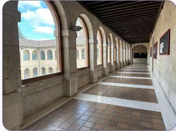
Pasillo superior patio
