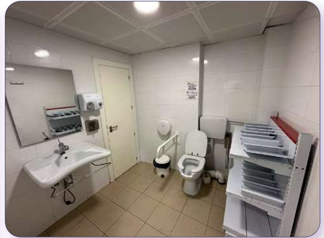
Interior del baño para PMR
