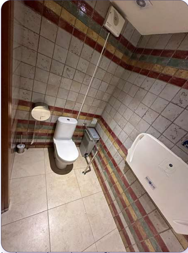
Inodoro con barra de apoyo fija
