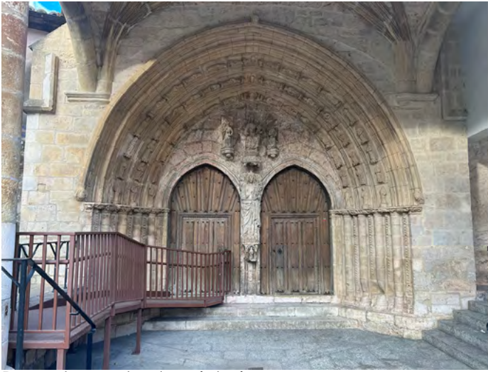
Pasarela y entrada a iglesia.
