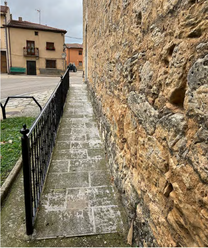
Rampa de acceso.
