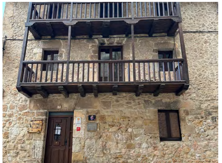
Fachada de casona con balcones de madera.
