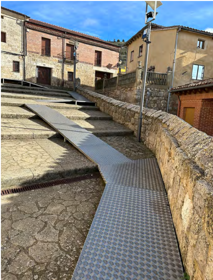
Imagen de rampas de acceso.
